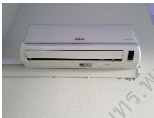
รูปที่ 2 ภาพติดตั้งคอยล์เย็นภายในห้อง
