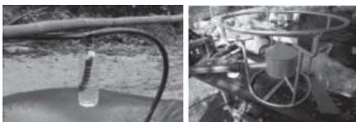
รูปที่ 9 การประกอบสายส่งแก๊สและติดตั้งขวดดักน้ำ
