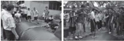
รูปที่ 7 การนำถุงหมักกลางหลุมและจัดวางให้เหมาะสม
